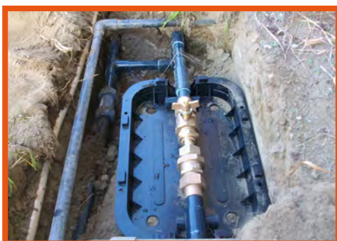
給水配管取出し口工事状況
