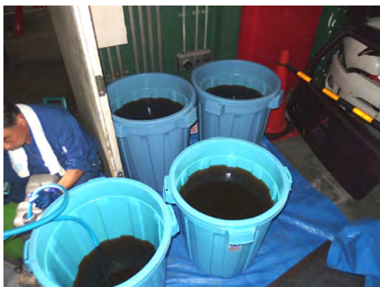
P-FOS 含有泡消火薬剤抜取り後、専門業者へ委託し廃棄します。
