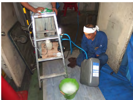
非 P-FOS 含有泡消火薬剤充填作業中
