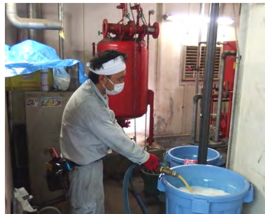
P-FOS 含有泡消火薬剤抜取り作業中
