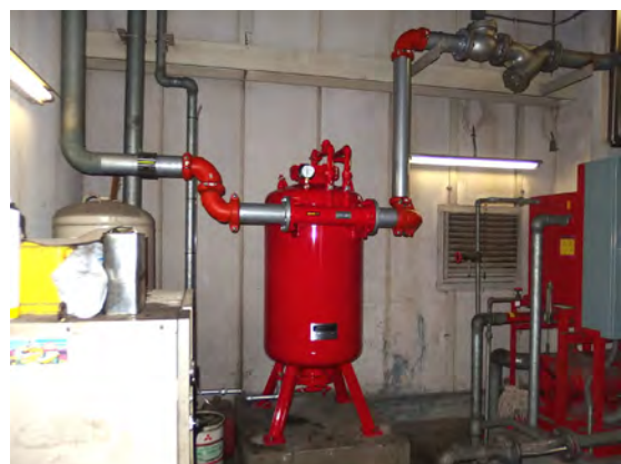
泡消火薬剤交換完了
