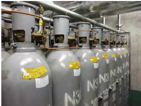
既存ガス容器撤去搬出前
