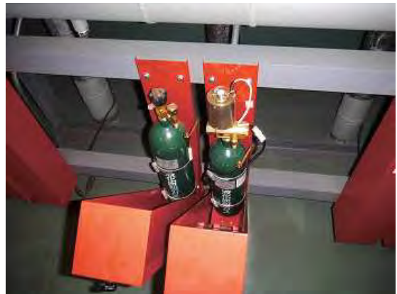
起動用 CO2 撤去搬出前
