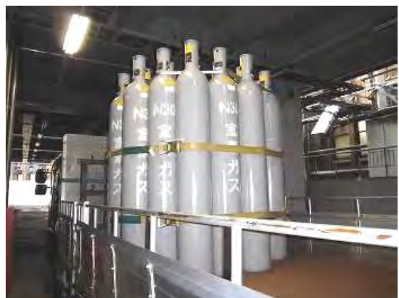
既存ガス容器搬出状況
