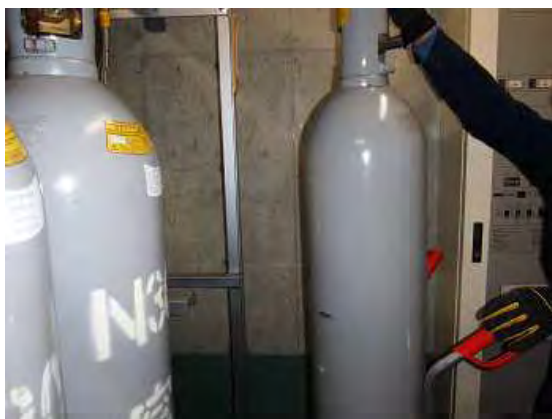
ガス容器撤去状況
